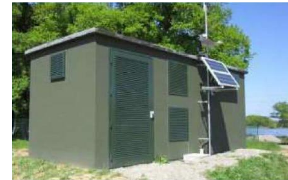
Illustration 15 : Poste de livraison
